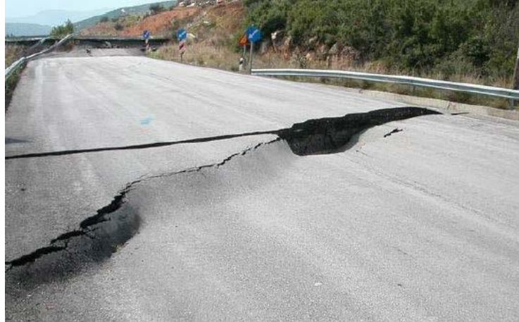
Figura 813 - 3. Falla de un terraplén bajo un pavimento
